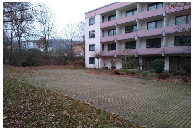
Hier wird für die BRK-Kinderkrippe in Lichtenfels umgebaut: Hinter dem Gebäude in der Nordgauerstraße wird der Außenspielbereich der neuen BRK-Kinderkrippe errichtet.
